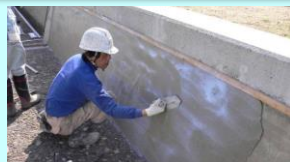
老朽化した水路壁のコーティング
