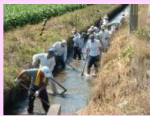
水路の泥上げ
