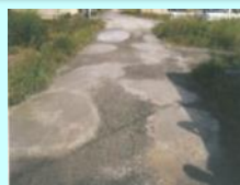
農道の窪みの補修
