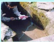
水路のひび割れ補修
