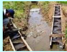
水田魚道の設置
