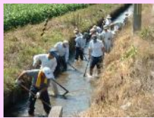
水路の泥上げ
