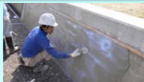
老朽化した水路壁のコーティング
