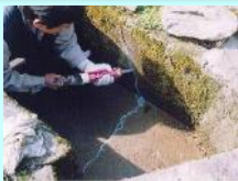
水路のひび割れ補修
