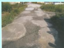
農道の窪みの補修
