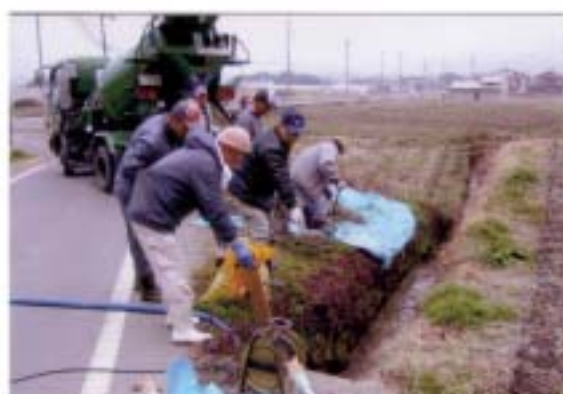
(誘導) 水路の目地詰め・破損箇所の補修(開水路・農道)
