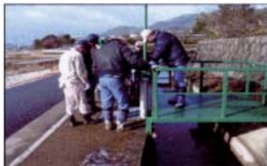
(基礎) ゲートの点検
