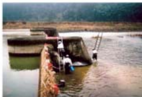
(基礎) 取水堰の点検・診断
