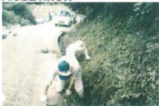
(基礎) 開水路の草刈作業
