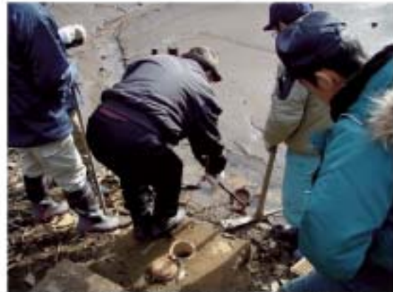
(誘導) ため池取水栓の確認及び点検
