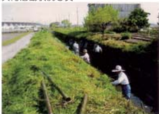
(基礎) 開水路の草刈・泥上げ
