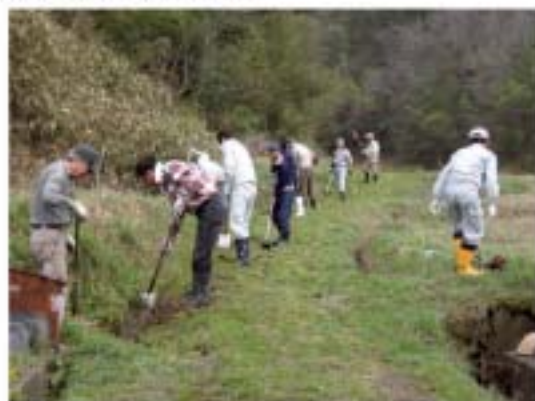
(基礎) 農道側溝の泥上げ・草刈り作業
