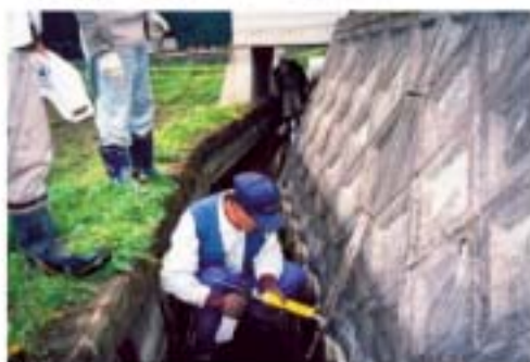
(誘導) 水路の点検・補修
