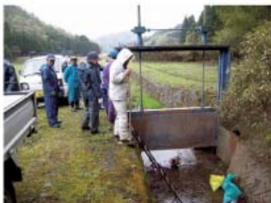
(誘導) ゲート類の保守管理
