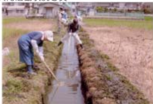
(基礎) 開水路の泥上げ作業
