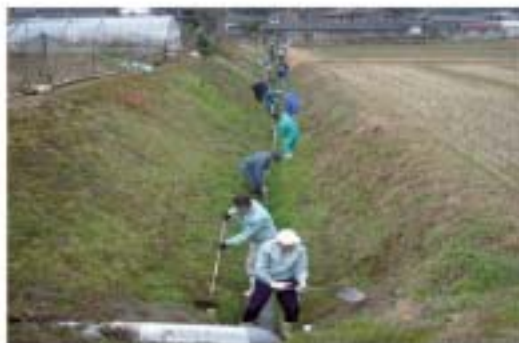
(基礎) 水路の泥上げ作業
