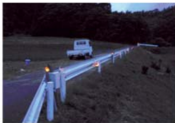
(誘導) ホタルの生息調査と鑑賞会 のための竹灯籠設置
