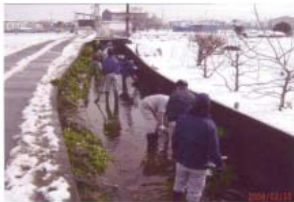
(誘導) 幹線水路の泥上げ作業(2月)
