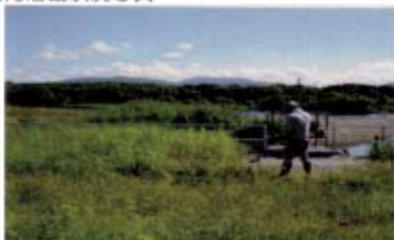
(基礎) 排水路の草刈り作業
