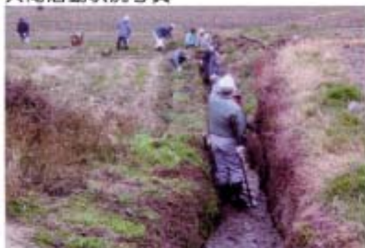
(基礎) 開水路の草刈り・泥上げ作業
