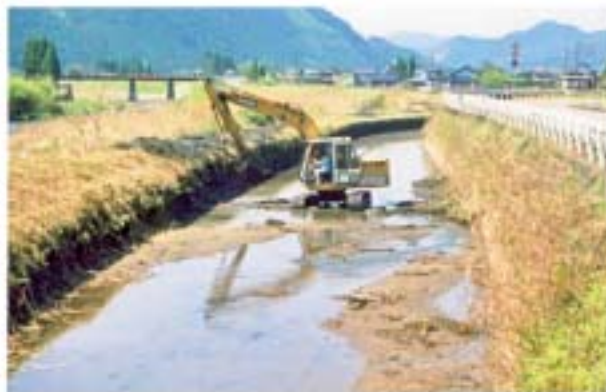
(誘導) 幹線用水路の浚渫
