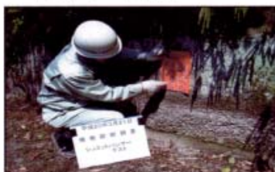
(誘導) 水路の機能診断
