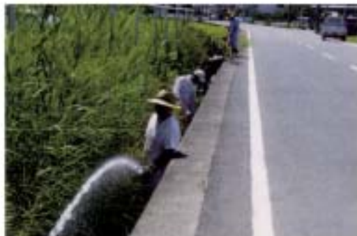
(基礎) 水路の藻等の除去
