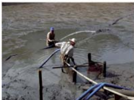
(誘導) ため池の水抜きによる点検・補修
