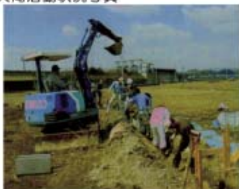
(基礎) 準幹線水路のU字溝敷設作業
