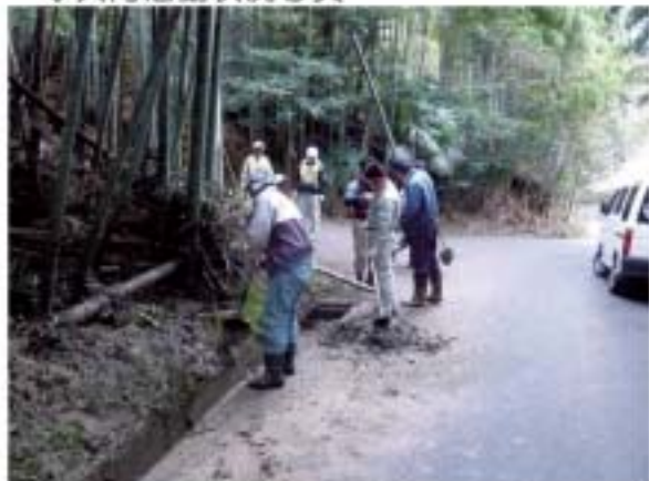
(基礎) 水路の泥上げ作業
