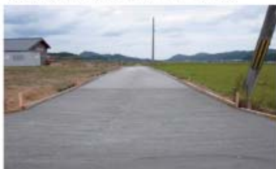
(誘導) 農道のコンクリート舗装
