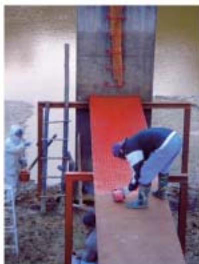
(誘導) 沈砂池管理構 錆止め塗装
