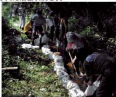
(基礎) 水路の泥上げ作業
