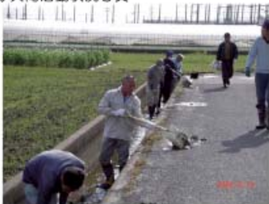
(基礎) 水路の泥上げ作業
