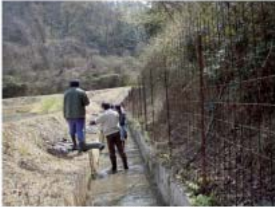
(基礎) 排水路の堆積土砂上げ
