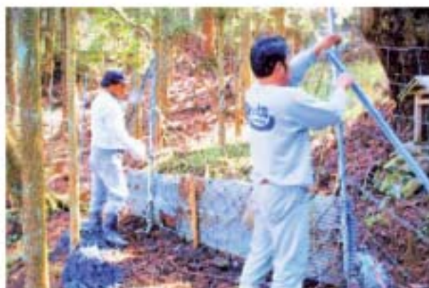
(誘導) 獣害防護柵の修繕作業
