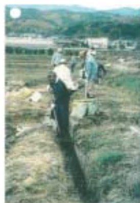
(基礎) 開水路の泥上げ作業
