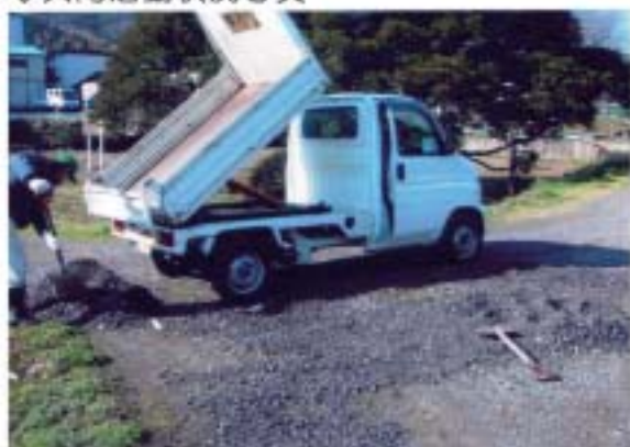
（基礎）農道の砂利補充作業
