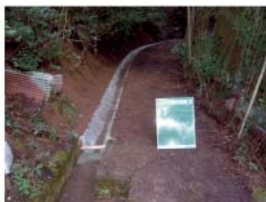
水路の布設（完成）
