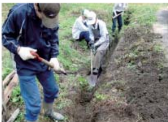
(基礎) 水路の泥上げ作業
