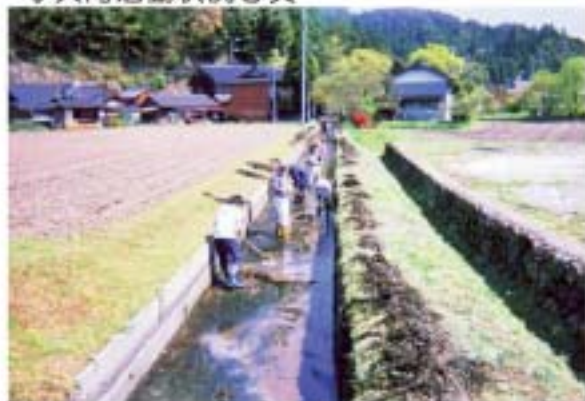
(基礎) 水路の泥上げ作業
