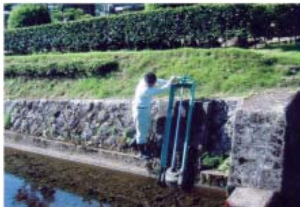
（誘導）取水ゲートの保守管理
