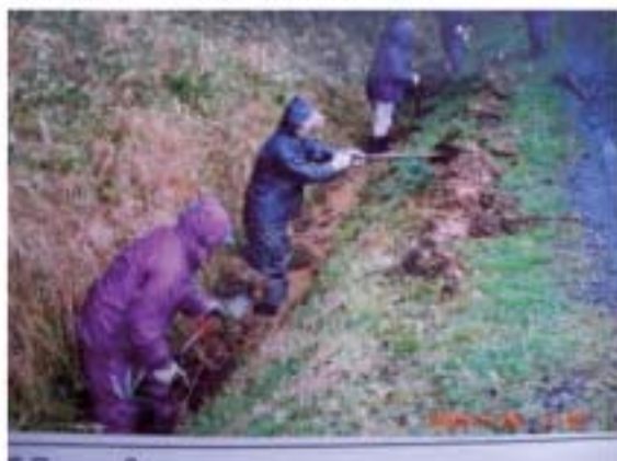
(基礎) 水路の泥あげ作業
