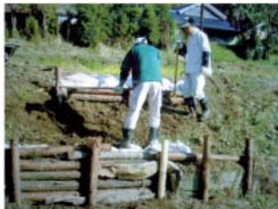
(誘導) 水路法面の補修
