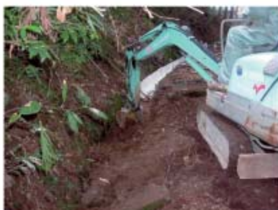
水路の布設（施工中）
