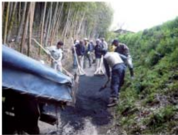
(誘導) 直営作業による農道のアスファルト舗装
