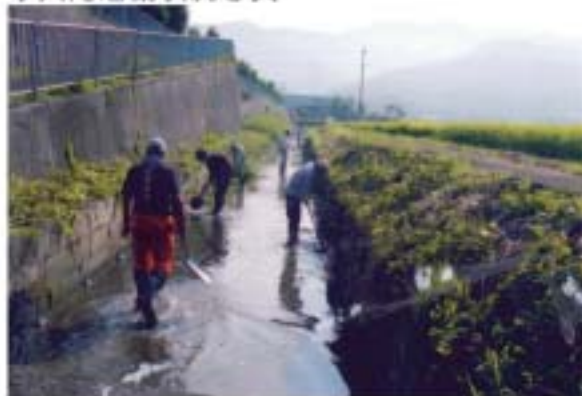
(基礎) 開水路の泥上げ作業
