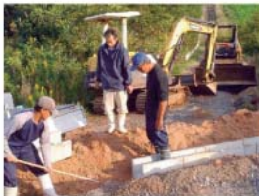
(誘導) U字溝の設置
