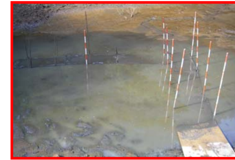
池底の真ん中に板式不沈通路を設置
