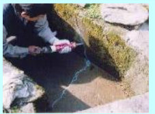
水路のひび割れ補修
