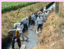
水路の泥上げ
