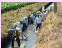
水路の泥上げ
