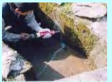
水路のひび割れ補修
