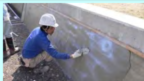
老朽化した水路壁のコーティング
