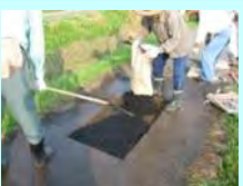
農道の部分補修
