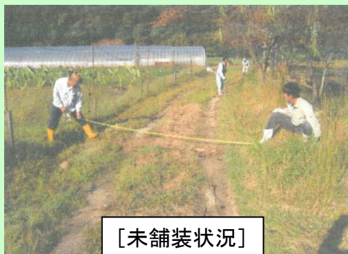
未舗装農道を舗装(コンクリート)
