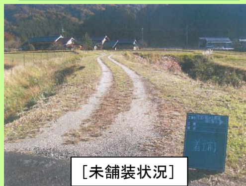
未舗装農道を舗装(アスファルト)
