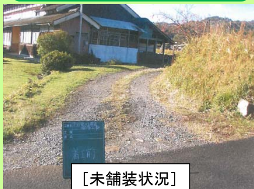
未舗装農道を舗装(アスファルト)
