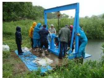
パイプラインの配水操作
