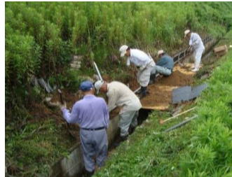
農用地法面の初期補修
