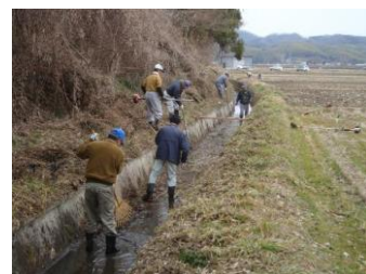
水路の草刈り及び泥上げ
